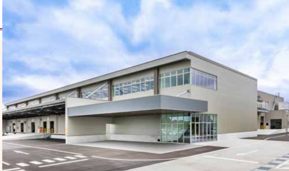
事業拡大に伴い2022年に稼働開始した浅井新工場
